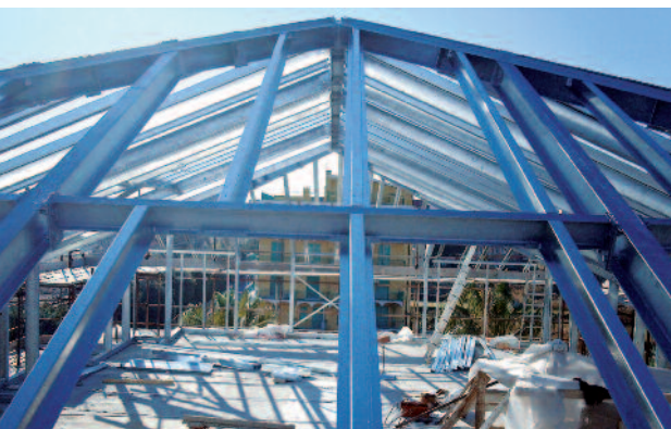
Qui, casa in acciaio in costruzione, con struttura riciclabile e ecosostenibile. Nella pagina a fianco, panoramica della serra fotovoltaica più grande d'Europa realizzata da Metalserra Srl, azienda diretta da Gianluca Gabbani (in foto) www.metalserra.it
